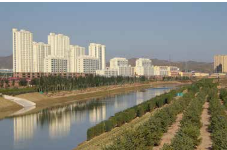
近年来包头投资 60 亿元，大力实施水流域污染防治工程及河道整治和黑臭水体治理，确保了水环境安全，改善了生态环境。图为市郊防洪沟治理工程
